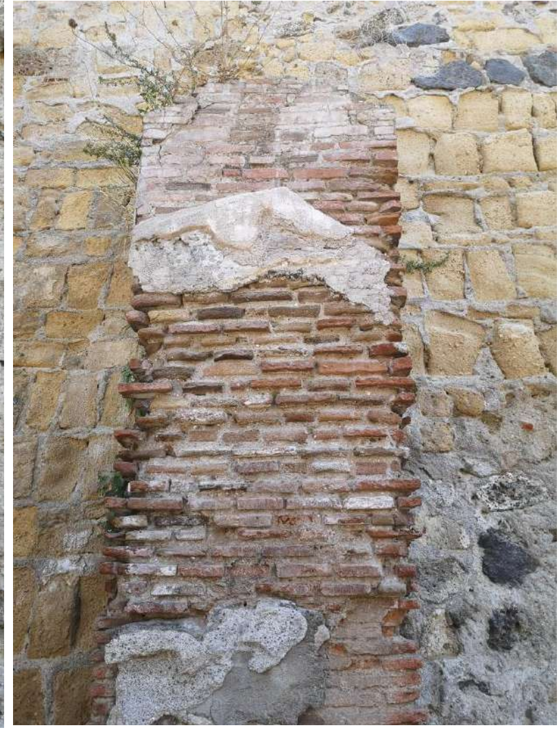
47. Decumano massimo, fronte scavi Nord Ovest, pilastro 2 visto da sud
