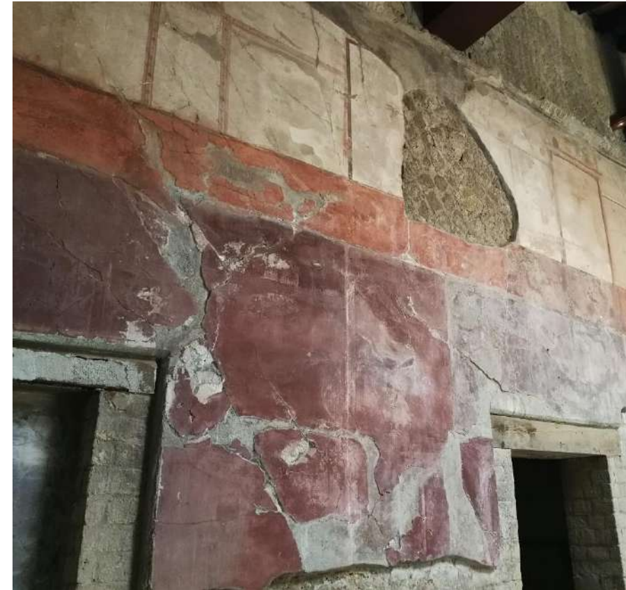
9. Vista da Ovest
