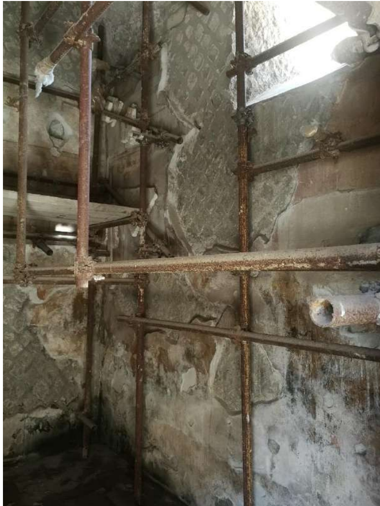
54. Ambienti di servizio dell'Area Sacra, ambiente 1 parete Est, visto da Ovest
