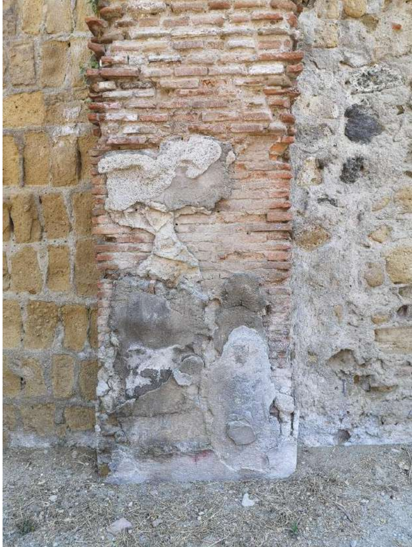
45. Decumano massimo, fronte scavi Nord Ovest, pilastro 1 visto da sud
